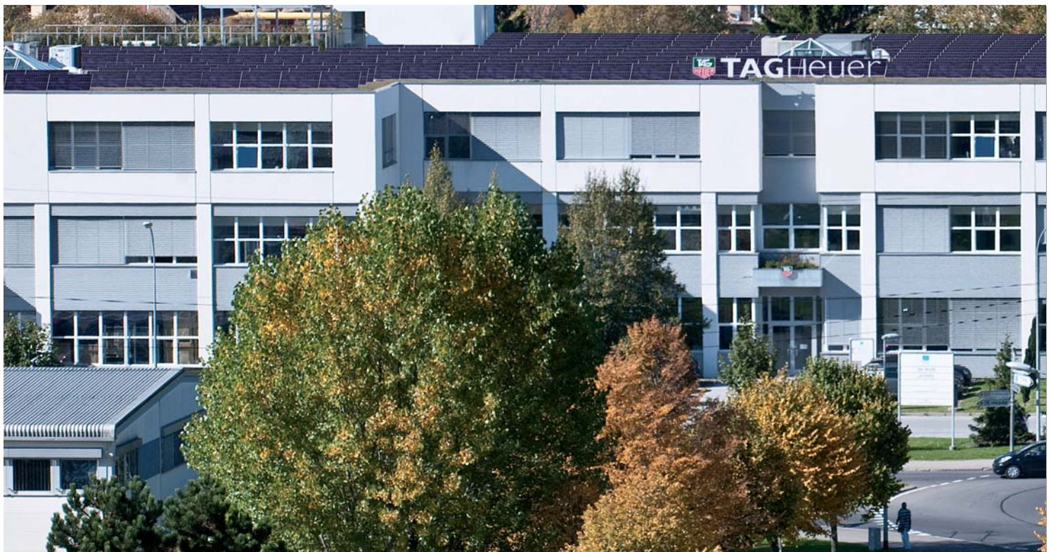
TAG Heuer installe 750 m 2 de panneaux photovoltaïques sur les toits de ses bâtiments de La Chaux-de-Fonds.
